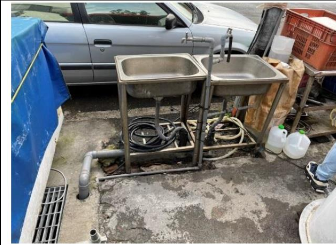
屏東縣—墾丁大街 設置餐洗碗槽並統一收集污水
