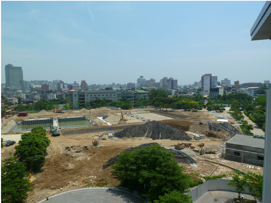
礫間處理槽體施工中（101年5月）
